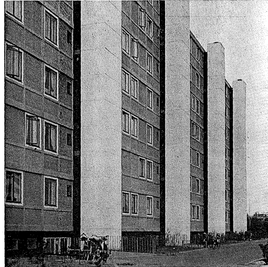
Blokkenes østside med de kraftigt markerede trappetræ til venstre.
