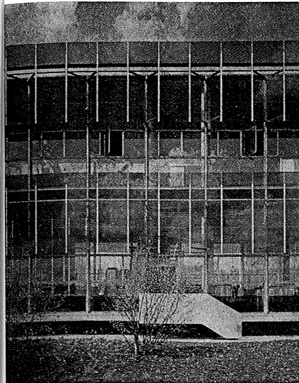
For firmaet Van Leer har arkitekten Marcel Breuer opført en administrationsbygning udenfor Amsterdam. Lige som ved UNESCO-bygningen i Paris, er her arbejdet med udvendige „markiser“ af varmeabsorbende glas. Efter Architectural Record nr. 8/1959.
