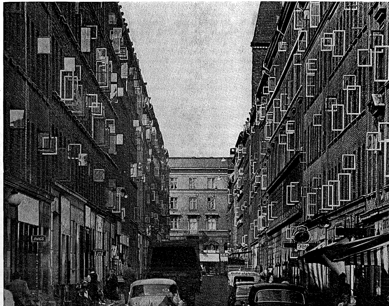
Der må være fugeproblemer her!
