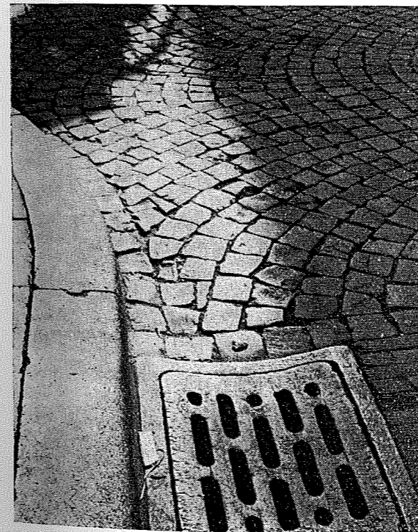
Det er karakteristisk for de traditionelle materialer, at overfladerne forskønnes gennem slid og tilsmudsning. Forholdet er her illustreret med noget så udsat som rødestenen med dens brolægning og støbejernrist. På lodrette murflader vil regnvandets patineringsvirkning være mere udtalt. Efter The Architectural Review nr. 636/1949.
