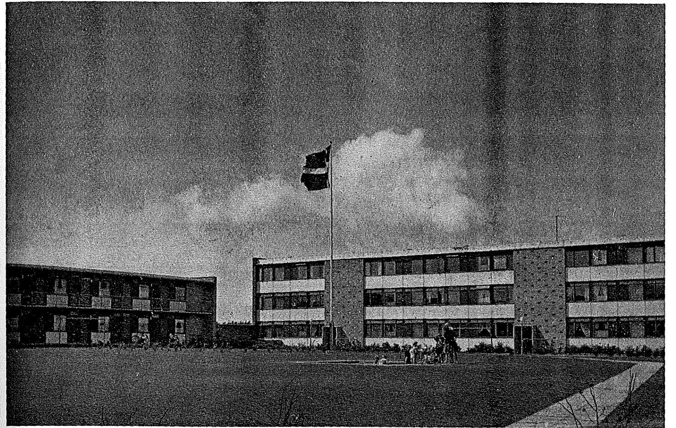
En allangangsblok til venstre og en 3 etagers blok midtfor.
