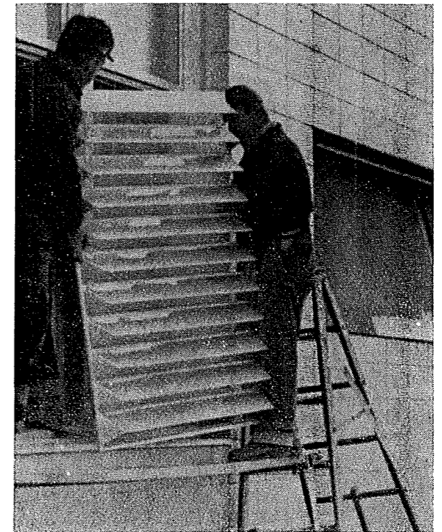
Med de nyere kunststofprodukter forholder det sig anderledes. Polyesterenheder er smukkeste den dag, de leveres fra fabrikken, hvorefter de estetik set gradvis devalueres. Ved kemikernes arbejde med materialer og overflader må det ikke overses, at patineringsvirkning burde betyde en berigelse af disse bygningsdele. Efter Progressive Architecture, juni 1960.
